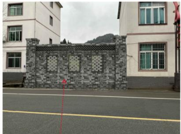
青砖砌墙，统一整体风格
